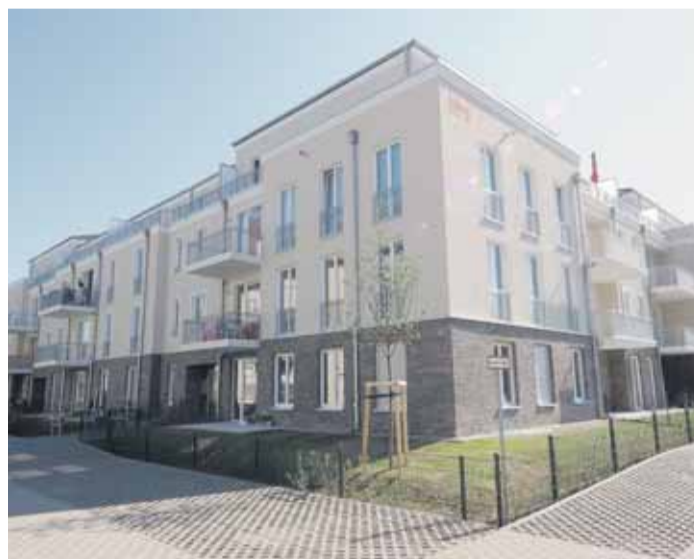
Die neue bbg-Wohnanlage „Carls Blüte“ in Karlshorst bietet Platz für 168 Wohnungen
